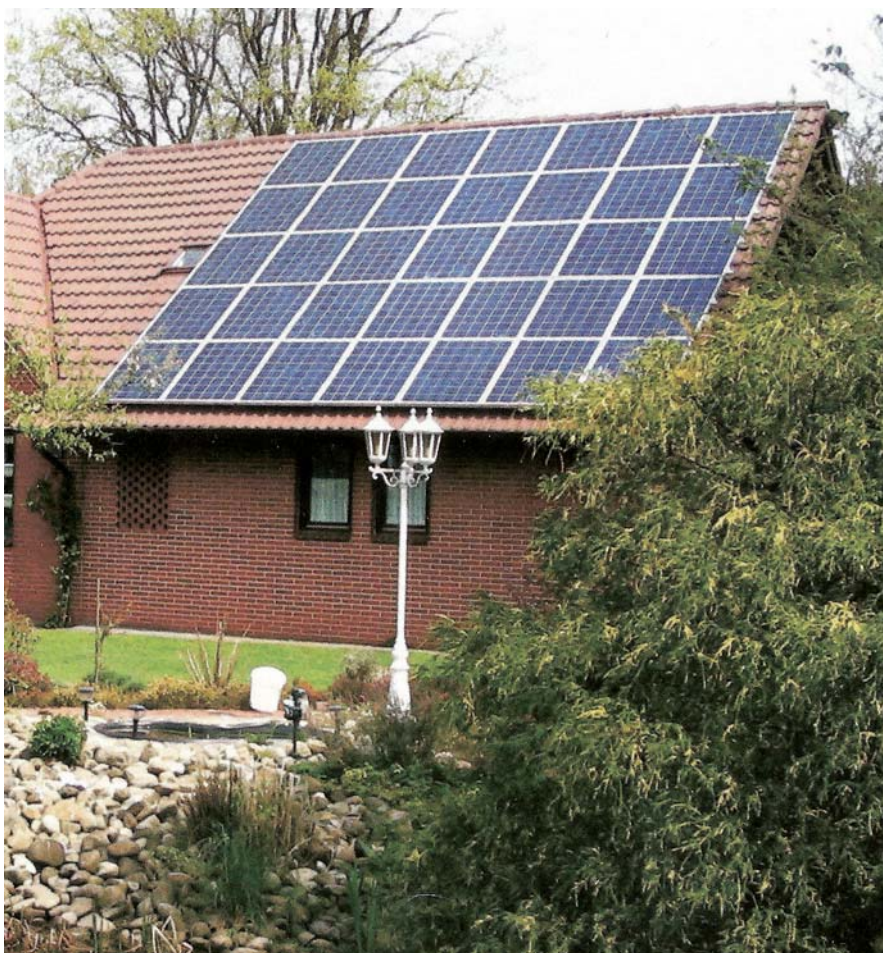
Rys. 1. Systemy fotowoltaiczne wymagają precyzyjnego zabezpieczenia przed przeciążeniami, zwarciami i przepięciami
